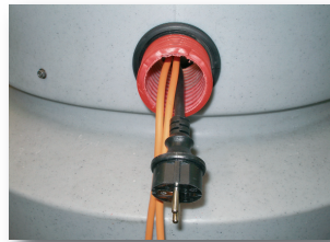
Passage de câbles
